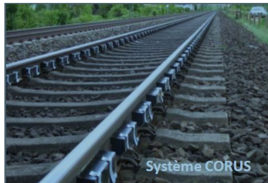
Exemple d'absorbeur dynamique sur rail
